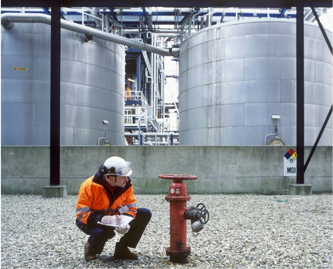
AFBEELDING 1 | chemische industrie installatie
